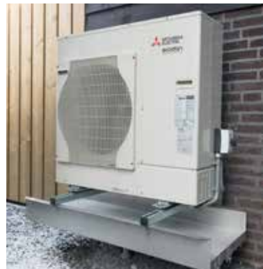
Aan de onderzijde van de buiten-unit loopt condenswater weg. Door middel van een lekbak en/of een grindpakket kan dit worden opgevangen.
