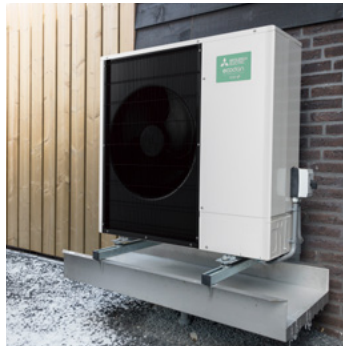
Een lekbak om water op te vangen
